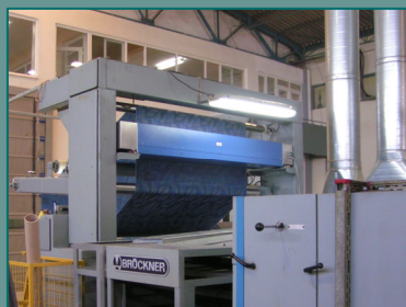
Lesebrücke SD 1 traversing (Auslauf) Reading bridge SD 1 traversing (outlet)
